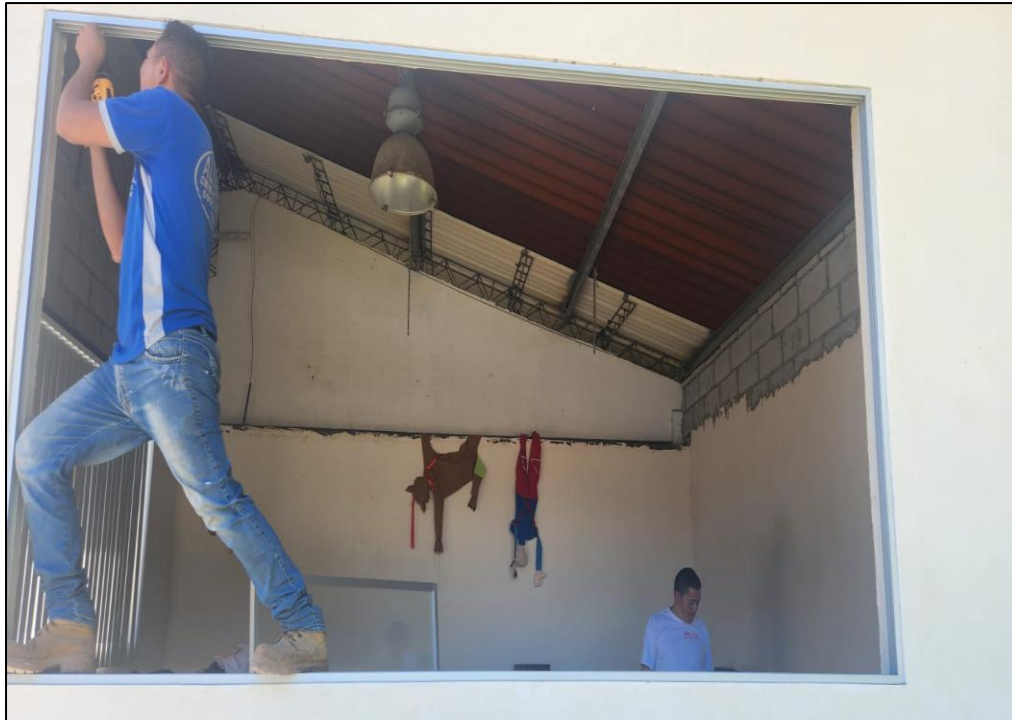
Gráfico 9. Proceso de instalación del marco aluminio y cortina de una ventana en el aula museo
