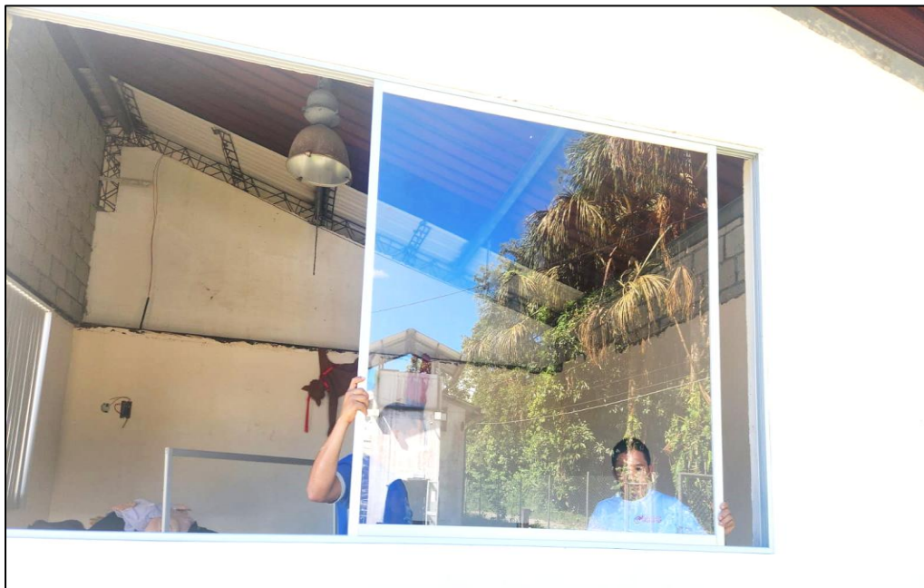
Gráfico 9. Proceso de instalación del marco aluminio y cortina de una ventana en el aula museo
